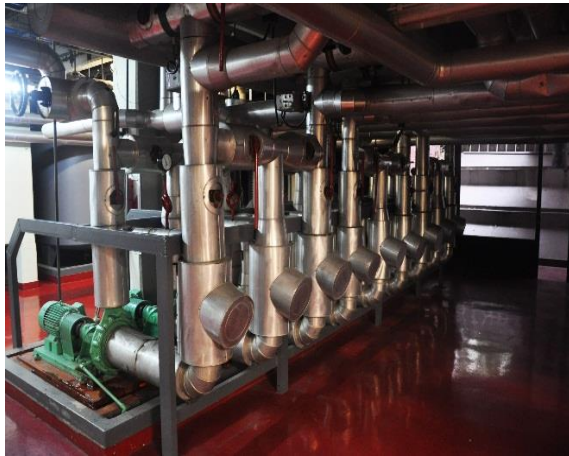
Salas de máquinas
