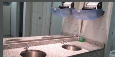
Batería de baños y office por piso.
